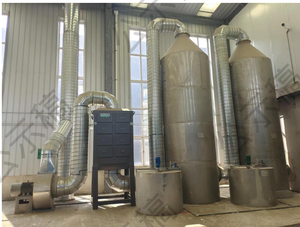
图 4-2 粪便处理车间废气除臭系统
