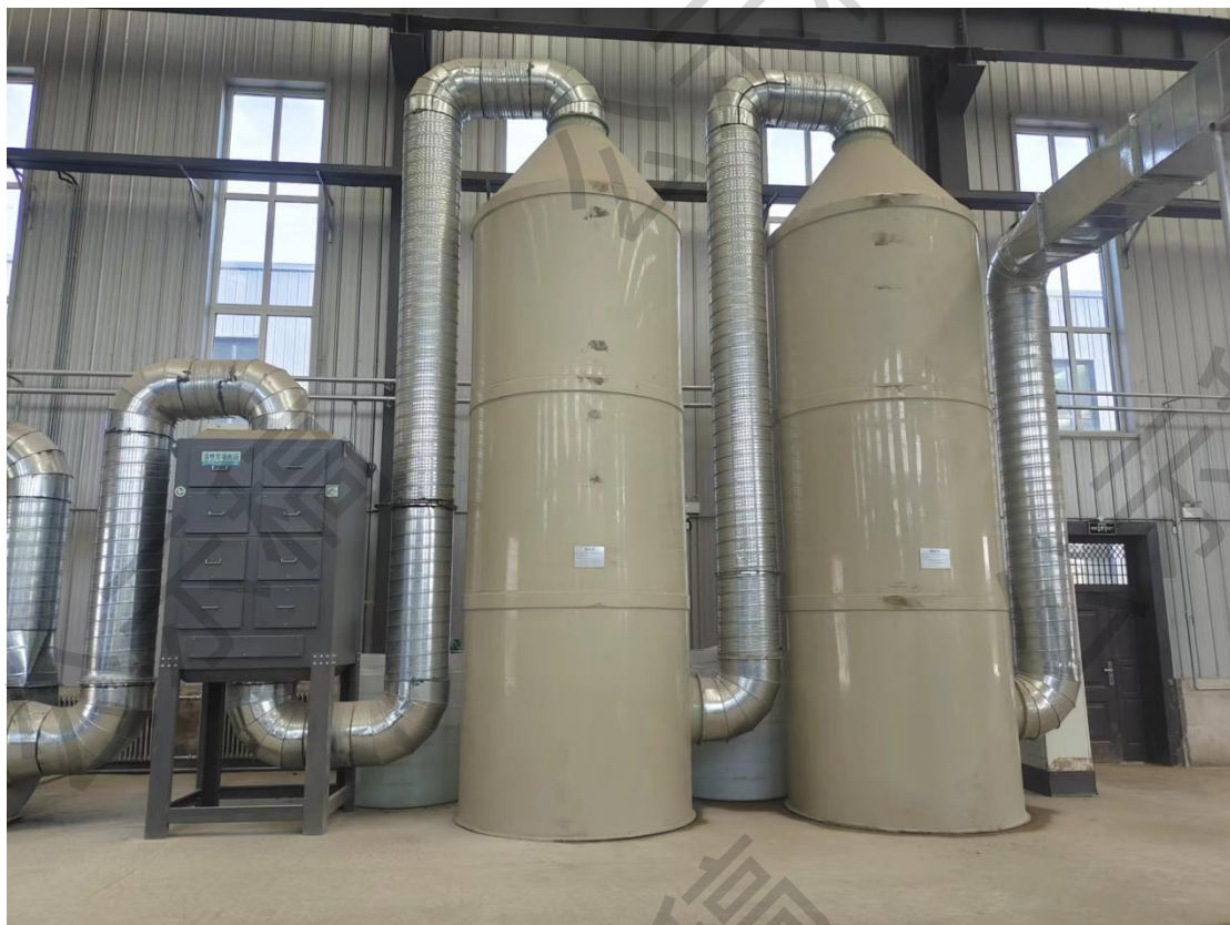
图 4-1 餐厨垃圾处理车间废气除臭系统
