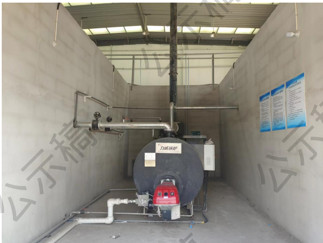
图 4-3 项目锅炉（配置低氮燃烧器）
