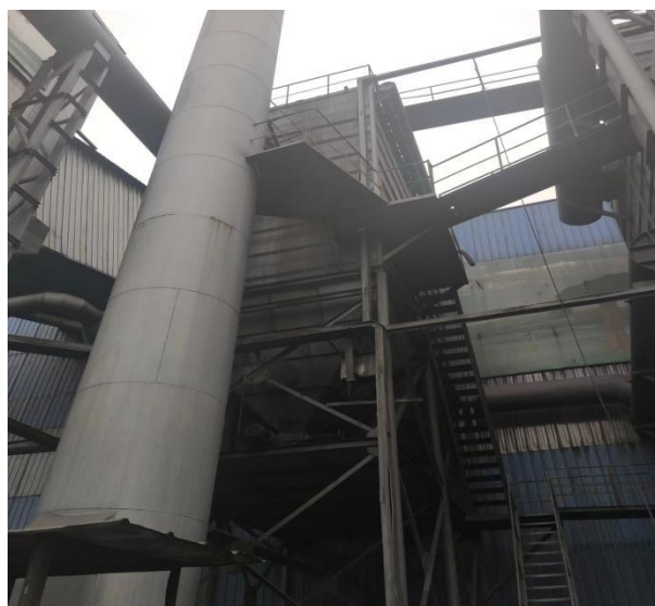
焦棚装焦口废气排气筒除尘器
