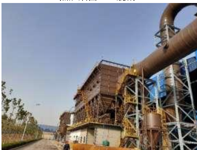
焦炉逸散烟气除尘器
