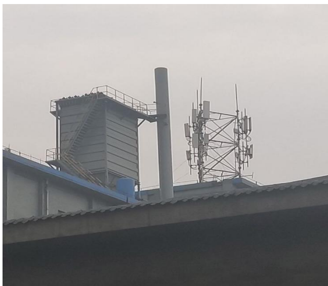
煤转运排气筒除尘器
