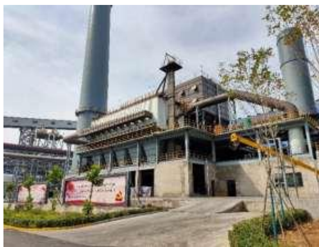
1#、2#推焦及机侧炉头烟气除尘器
