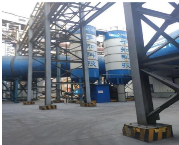
1#脱硫剂储罐
